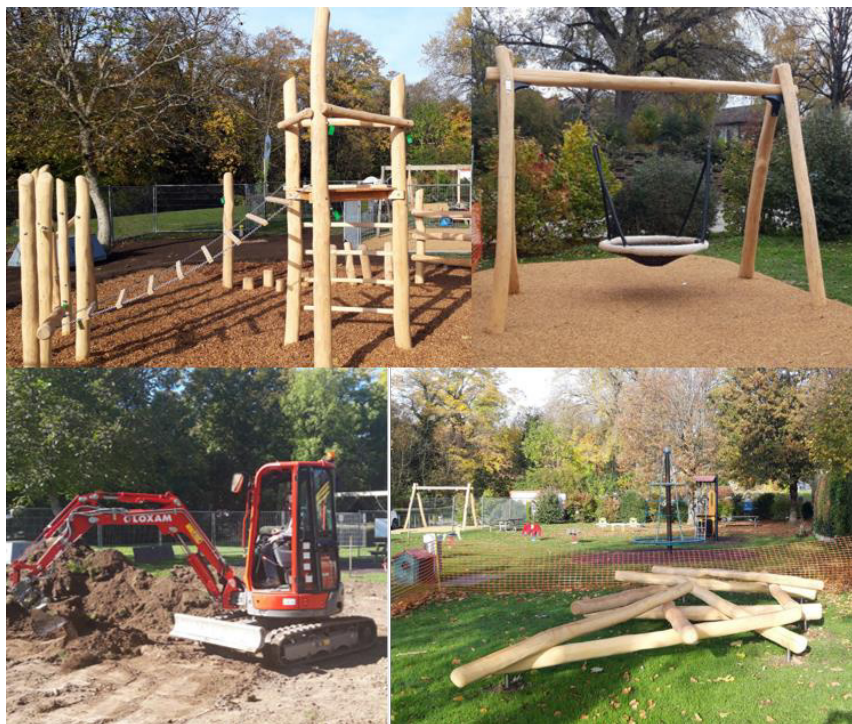
Les nouveaux aménagements ont nécessité des travaux importants de génie civil
